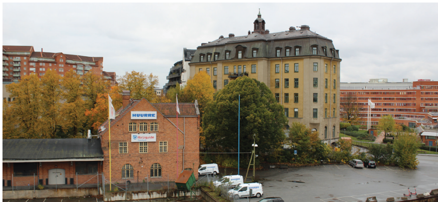
Liljeholmens stationshus med tillhörande godsmagasin är en av få bevarade byggnader inom programområdet. Byggnaden är grönklassad av Stadsmuseet, vilket innebär att den har ett högt kulturhistoriskt värde.
