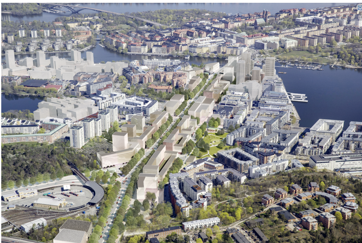
Illustrationer över programområdet sedda från norr och söder. I illustrationen är även planerad bebyggelse i Marievik inlagd samt pågående planering för Liljeholmens centrum och Lövholmen. (&Rundquist, Mandaworks)
