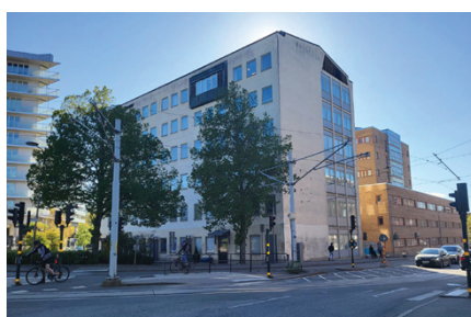
Fabriksbyggnad från 50-talet. Korsningen Liljeholmsvägen-Lövholmsvägen.
