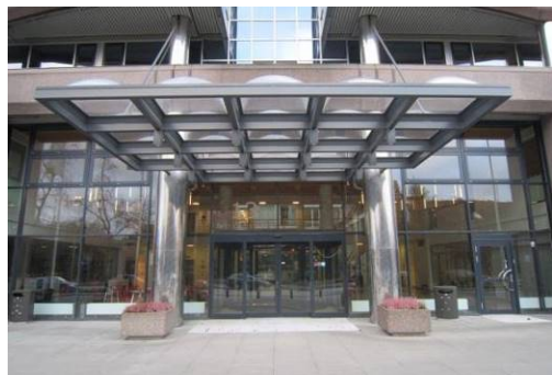
Pelare klädda i rostfri plåt
