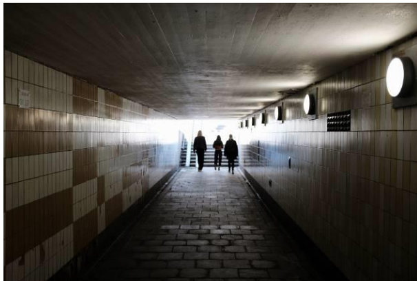
En av gångtunnlarna under Södertäljevägen
