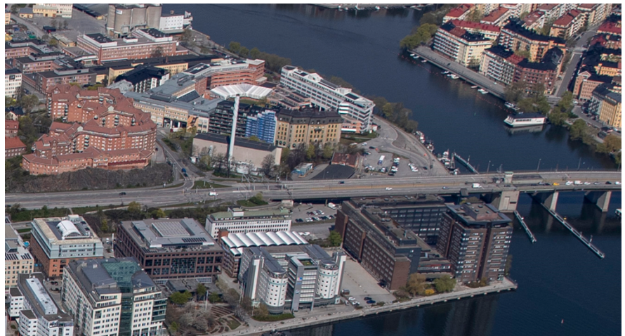
Flygfoto från 2021 som visar befintlig miljö. Centralt i bilden syns Ellevios befintliga transformatorstation. Idag har byggnaden nederst, till höger i bild, rivits.
