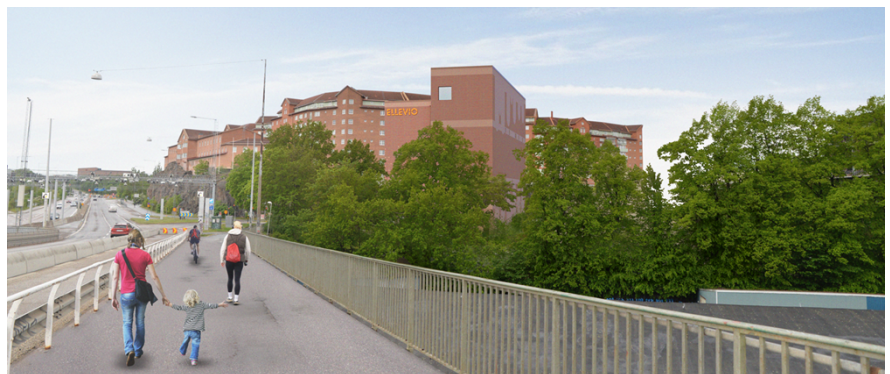
Transformatorstationen sedd från Liljeholmsbron. Bakom den nya byggnaden syns den befintliga bostadsbebyggelsen på Katrinebergshöjden. Urban Design
