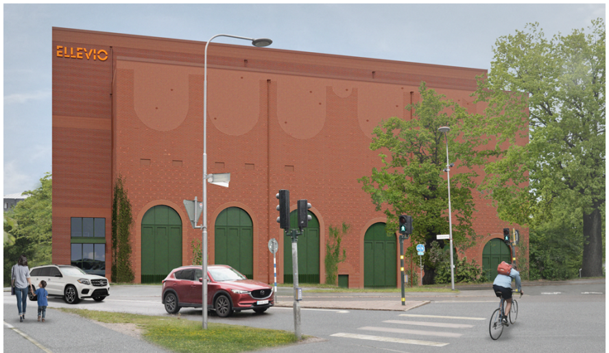
Transformatorstationen sedd från korsningen mellan Liljeholmsinfarten och Södertäljevägen. Urban Design
